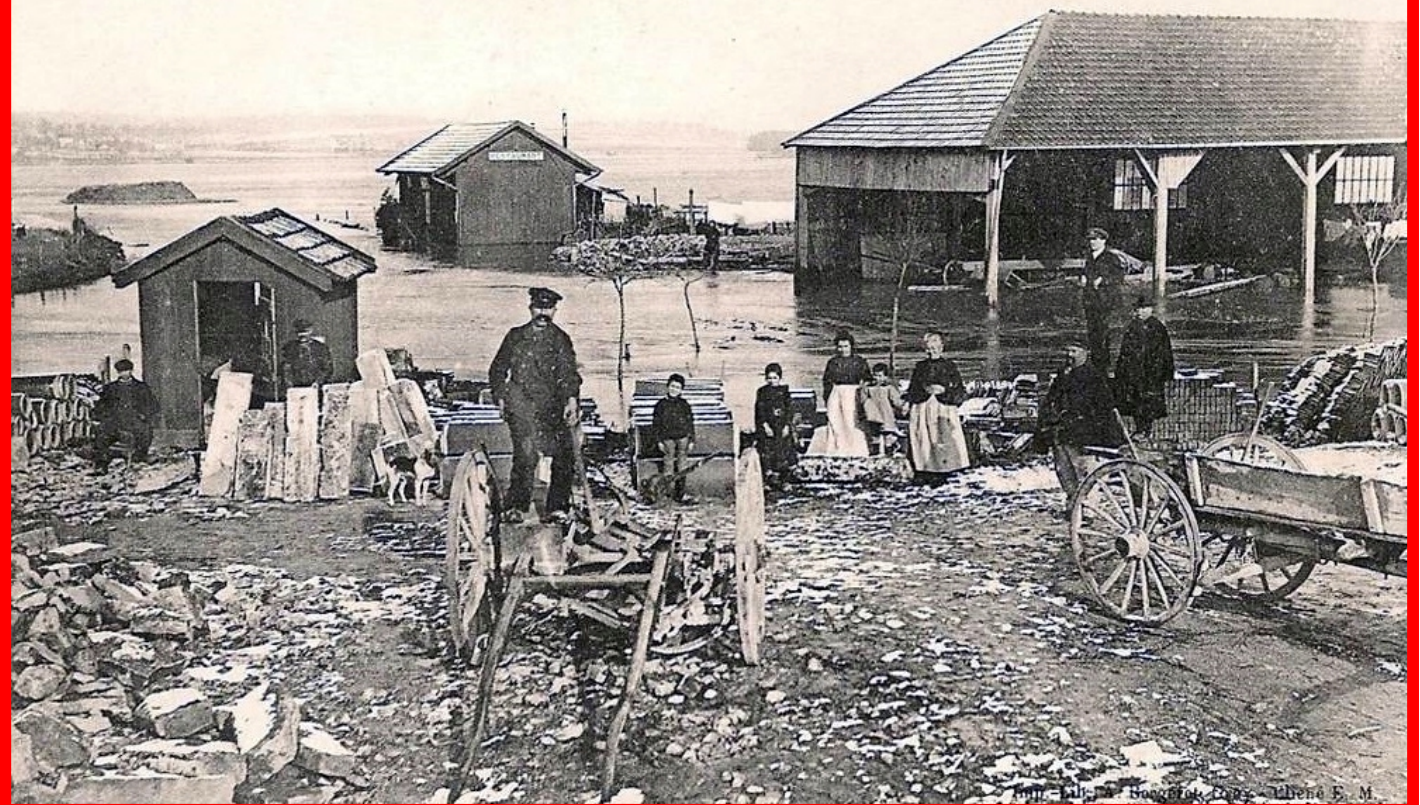
25. GRAY. - Crue de la Saône du 21 janvier 1910. - Inondation des chantiers Borne et Curaillat
