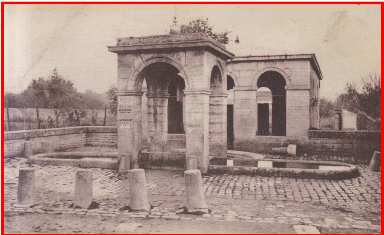
LA FONTAINE DE LA MAISON DU BOIS
