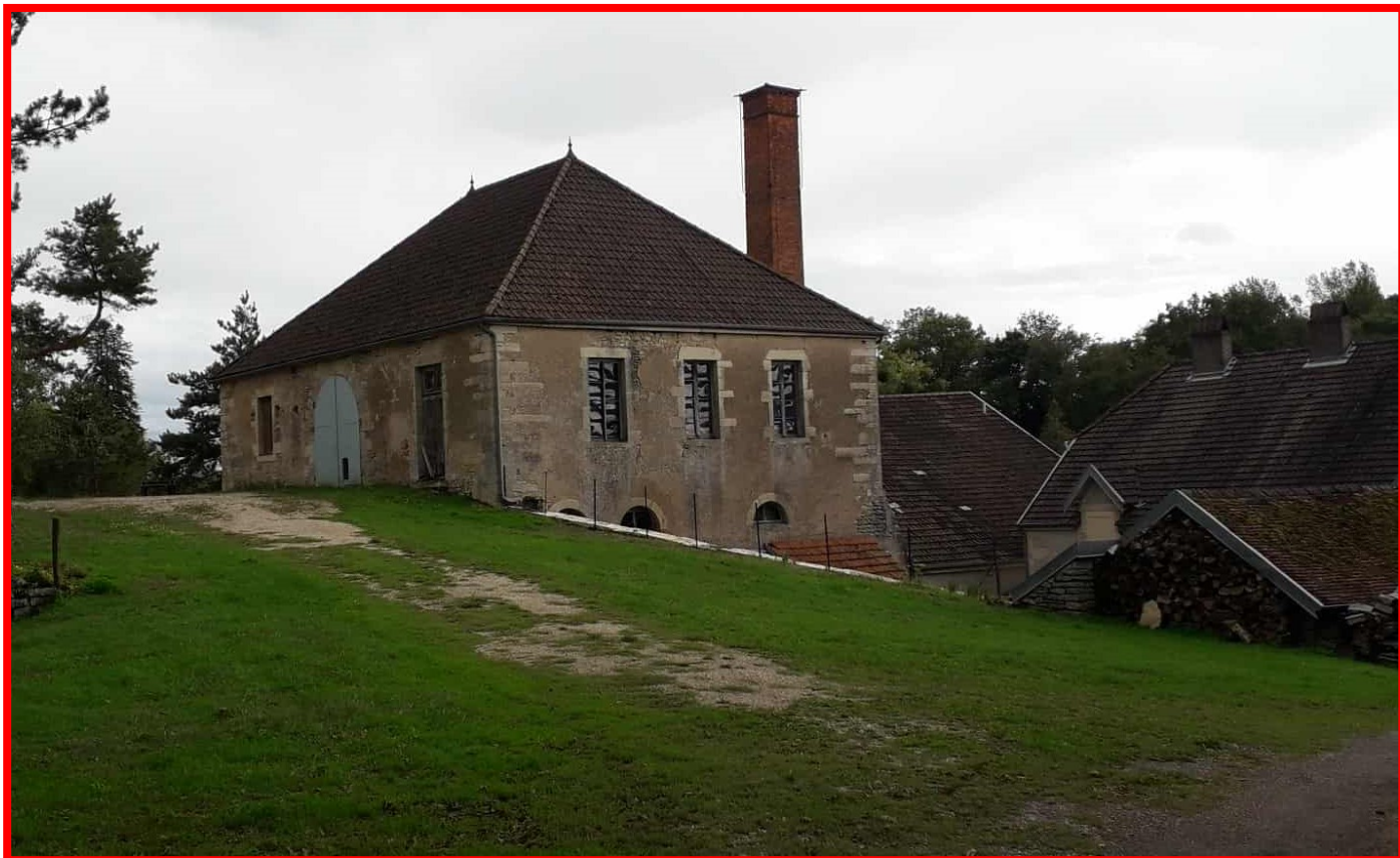
Ci-dessus l'étage supérieur du haut fourneau par lequel le minerai et le charbon de bois était chargé.
